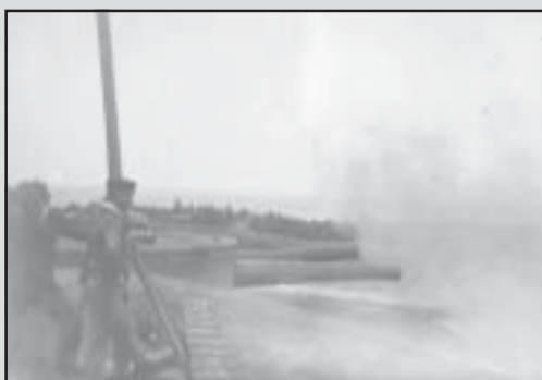
Här har man kommit till skott från batteri E 1 på Ellenabbsfortet. Eldgivning från detta batteri var ganska ovanligt, eftersom pjäserna hade en tendens att ständigt krångla. Fortet anlades åren 1900-1904 och kan närmast betraktas som ett pansarskepp i sten och betong på land. Pjäserna i batteri E 1 (3st 25 cm kanoner i dubbeltorn) kom från pansarskeppen Svea, Göta och Thule och var i princip omoderna, när de sattes upp. De utgick ur organisationen i samband med 1936 års försvarsbeslut och skrotades året efter.
